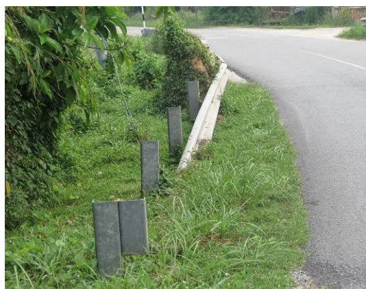
Gambar 2.23 Guardrail Tertanggal
