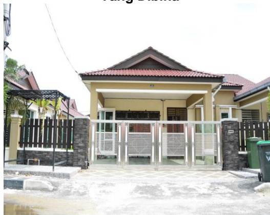
Gambar 1.2 Rumah Berkembar 1 Tingkat Yang Dibina
