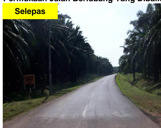
Gambar 2.18 Permukaan Jalan Berlubang Yang Dibaiki
