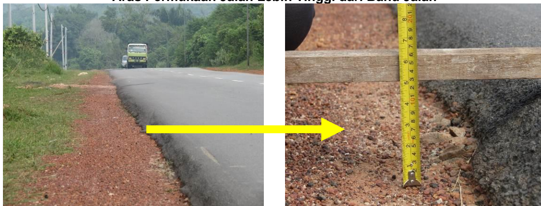
Gambar 2.29 Aras Permukaan Jalan Lebih Tinggi dari Bahu Jalan
