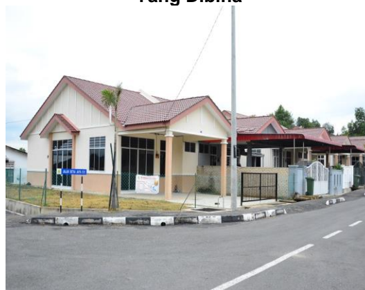
Gambar 1.4 Rumah Berkembar 1 Tingkat Yang Dibina
