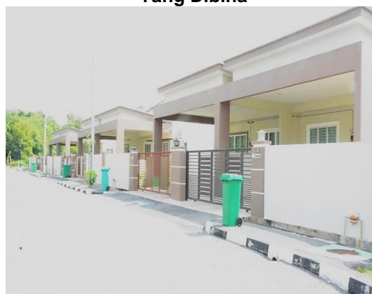
Gambar 1.9 Rumah Berkembar 1 Tingkat Yang Dibina
