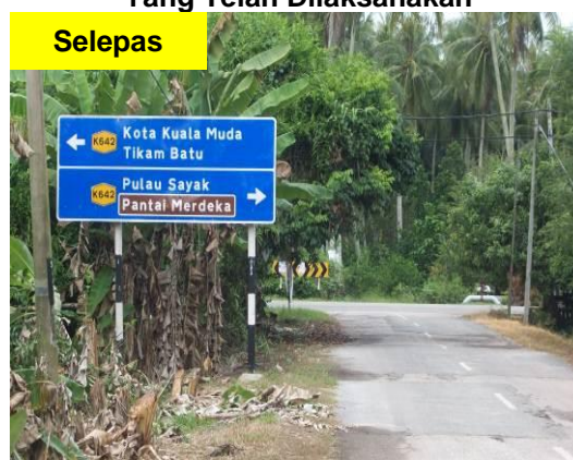
Gambar 2.20 Penyenggaraan Papan Tanda Yang Telah Dilaksanakan
