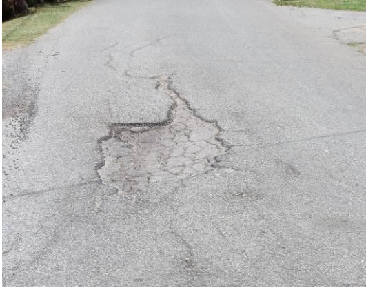
Gambar 2.12 Kerosakan Jenis Pengelupasan
